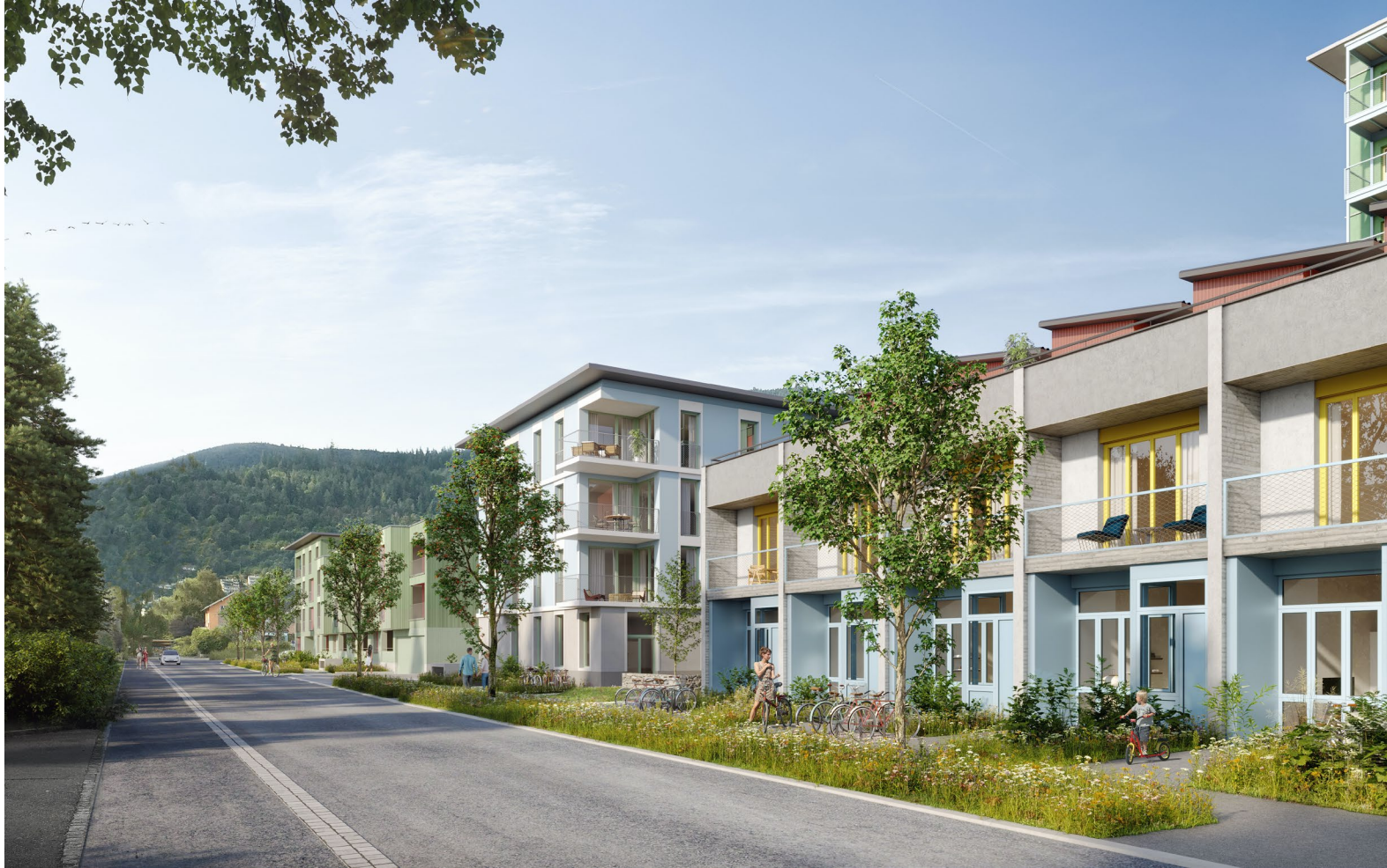
Façade ouest – Rue Jakob
